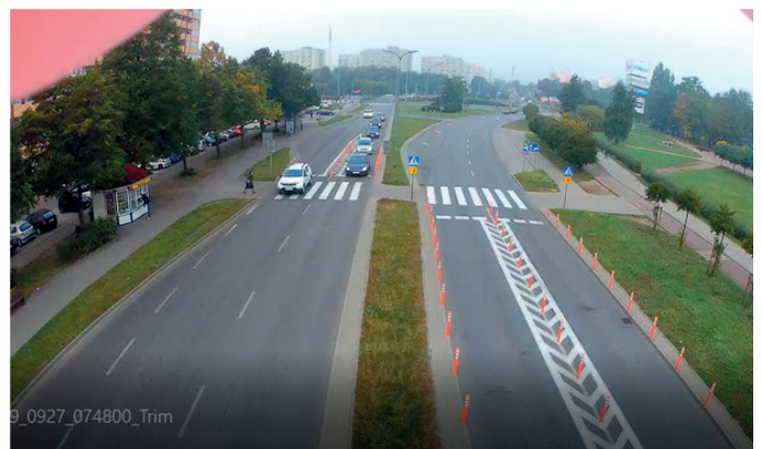
Fot. 7. Przykład zaobserwowanych sytuacji niebezpiecznych po modernizacji. Źródło: opracowanie własne
