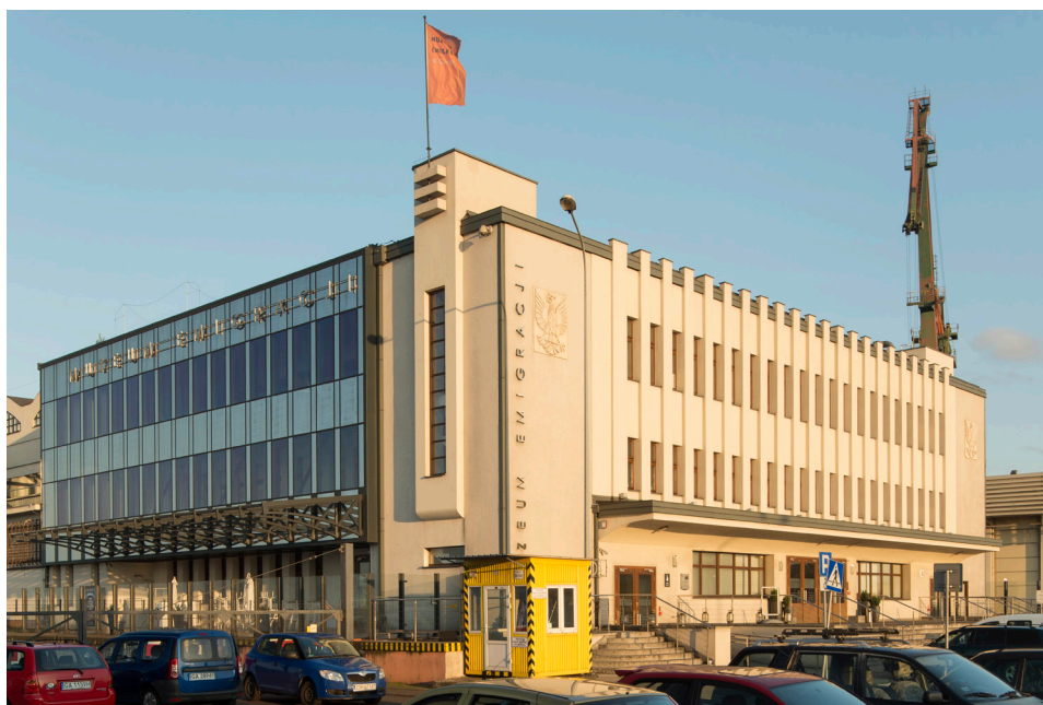
Ryc. 3 Gdynia. Dworzec Morski, zrekonstruowana fasada i przeszklona boczna elewacja, 2017 r., fot. B. Ponikiewski
