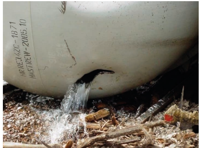
Rys. 9. Negatywny wpływ katastrofy kolejowej na podtorze Katastrofa w Szczygłowicach 23.05.2002 [11]
