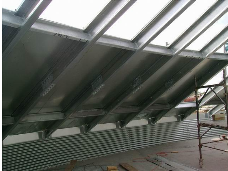
Rys. 3.13. Konstrukcja dach krokwiowy w fazie montażu [I1]
