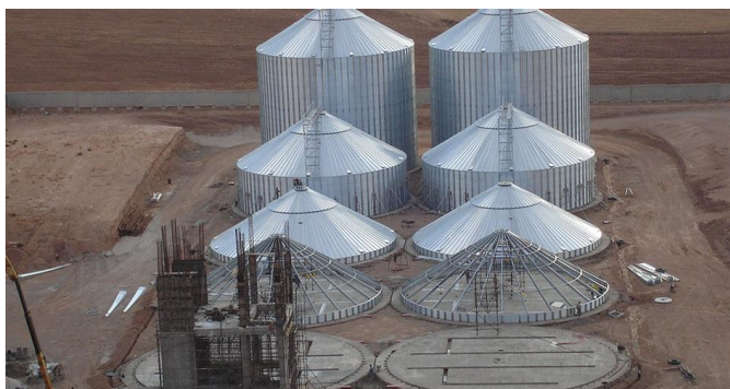
Rys. 3.2. Bateria silosów w różnych fazach budowy [13]
