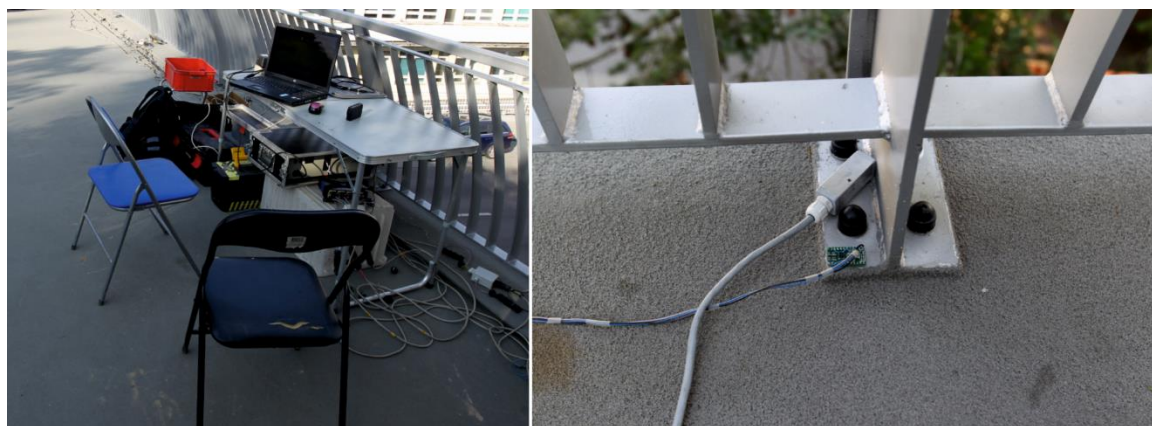
Rysunek 6.44 Stanowisko pomiarowe oraz montaż czujników na kładce na ul Chwarznieńską w Gdyni
