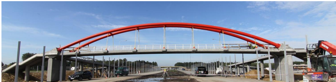
Rysunek 6.6 Widok na kładkę nad drogą S8.
