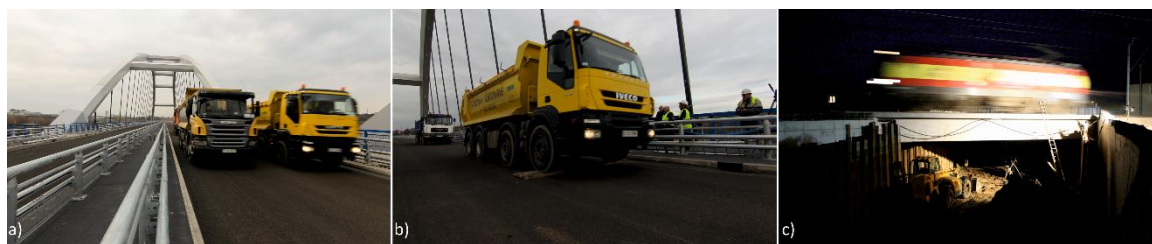
Rysunek 6.2 Metody wzbudzenia dynamicznego mostów i wiaduktów a) przejazd samochodu po gładkiej nawierzchni z różnymi prędkościami b) przejazd samochodu przez próg c) przejazd lokomotywy z różnymi prędkościami
