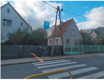
Fot. 6. Brak rampy na przejściu dla pieszych (fotografia – zasoby własne autorek)
