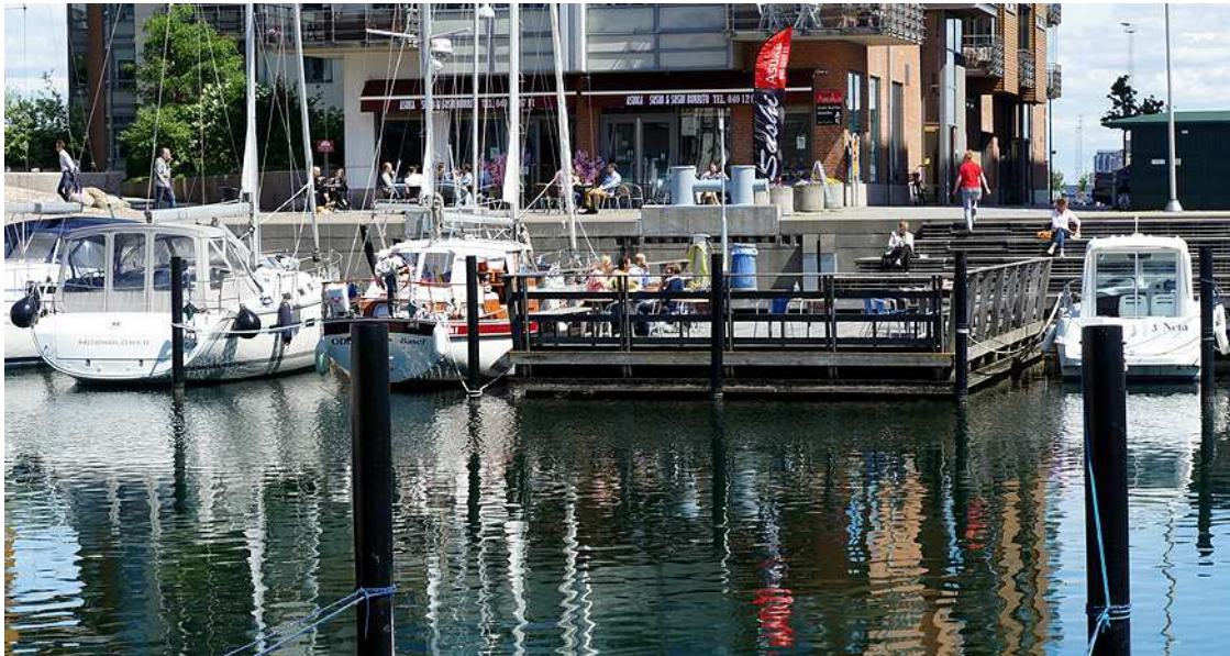
Fot. 68. Dockan Marina – pływająca platforma. Fot. Katarzyna Rembarz (27.05.2016)
