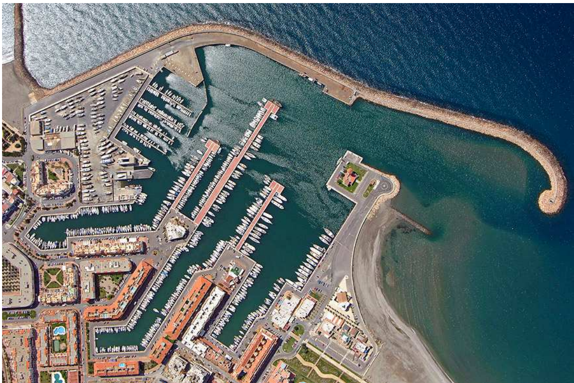
Fot. 40. Puerto Deportivo Almerimar.
