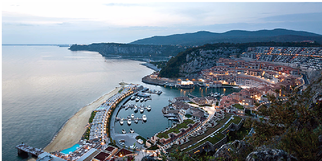
Fot. 35. Portopiccolo Sistiana – dawny kamieniołom zaadaptowany na kurort. Źródło: http://www.portopiccolosistiana.it/it/residenze/residenze_21.htm [dostęp: 07.03.2019]
