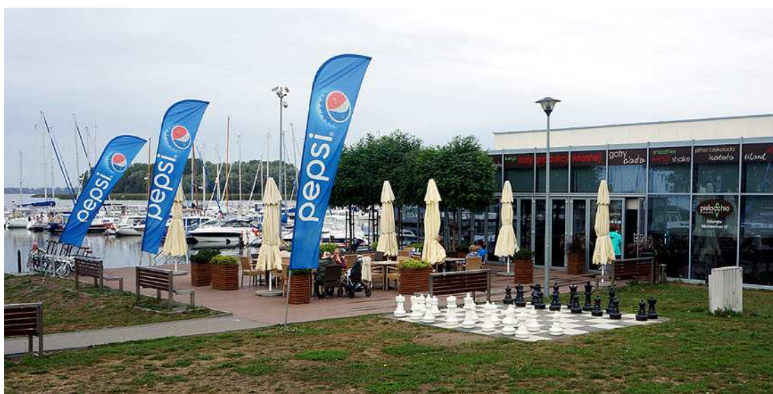
Fot. 97. Pawilon administracyjny z restauracją oraz skwer rekreacyjny. W głębi port jachtowy. Fot. Katarzyna Rembarz (11.09.2018)
