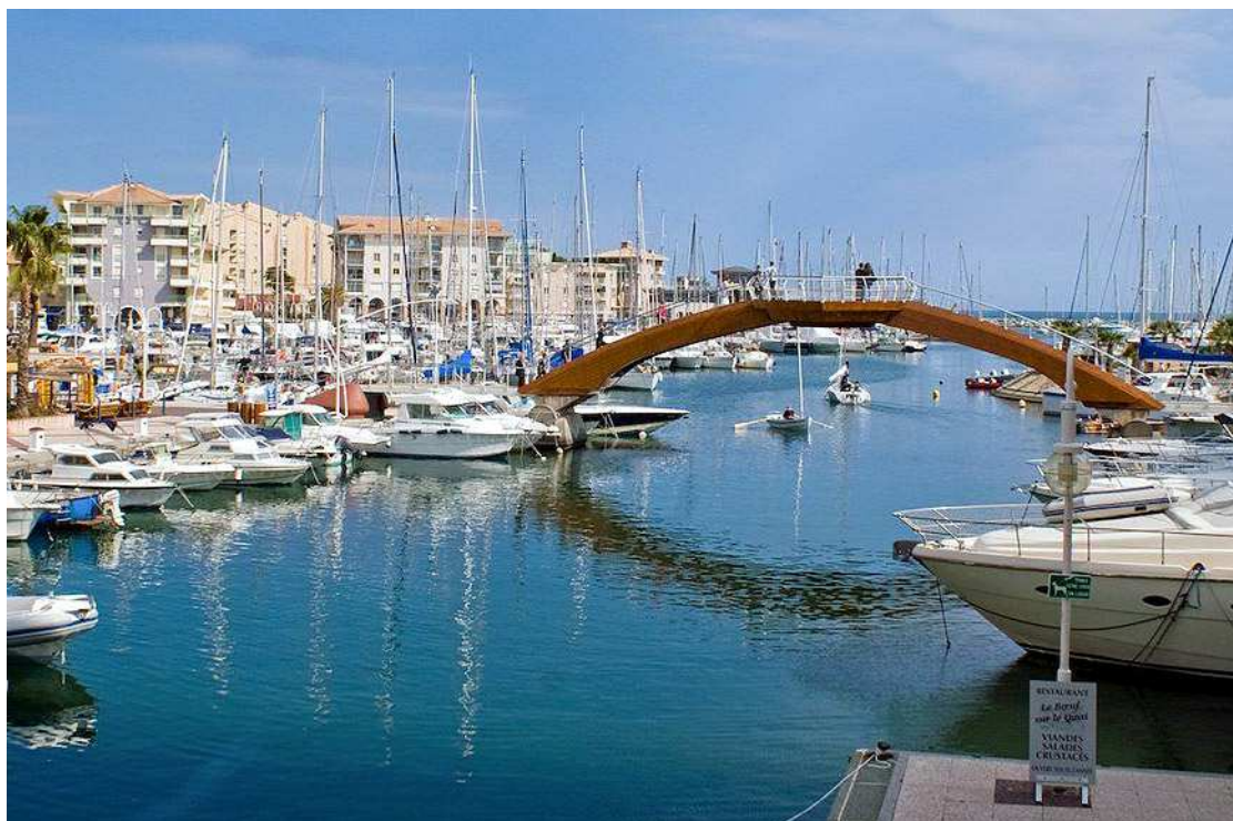
Fot. 74. Most z platformą widokową łączący przeciwległe brzegi.
