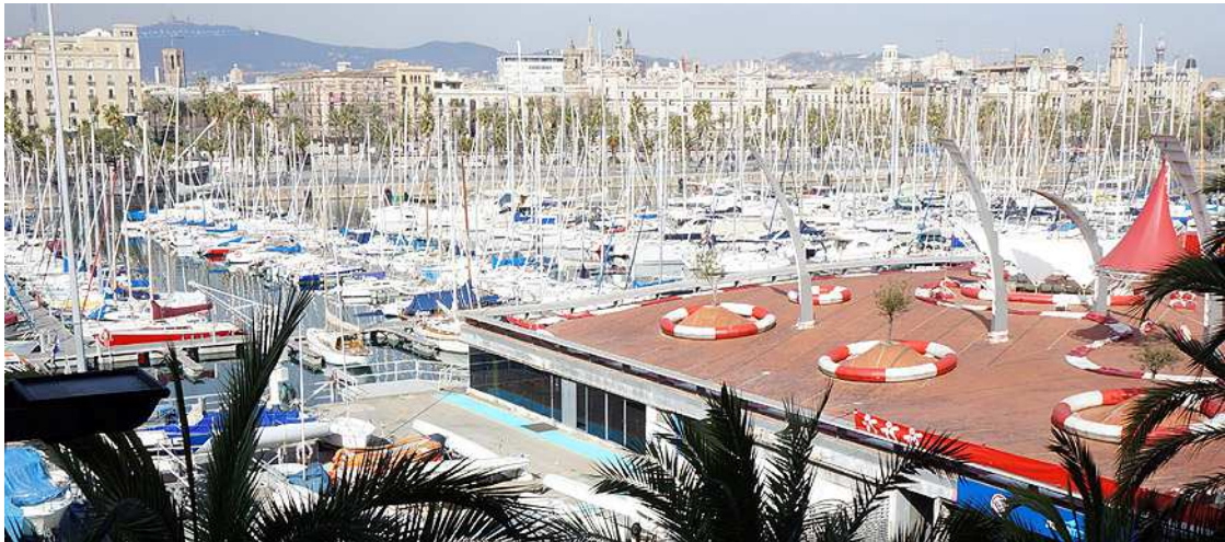
Fot. 61. „Reial Club Marítim de Barcelona” – dach hangaru wykorzystany jako plac miejski. Widok z okna sąsiedniego budynku. Fot. Katarzyna Rembarz (12.02.2015)
