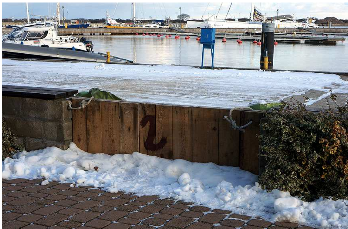
Fot. 2. COSA AZS w Gdańsku-Górkach Zachodnich. Murki betonowe i „wrota” przeciwpowodziowe umocnione workami z piaskiem oddzielające taras restauracji od nabrzeża. Fot. Katarzyna Rembarz (17.01.2016)
