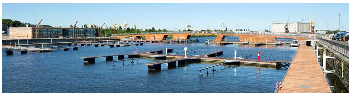
Fot. 85. Przystań jachtowa i most na kanale Duńcy – widok od strony południowo-zachodniej.
