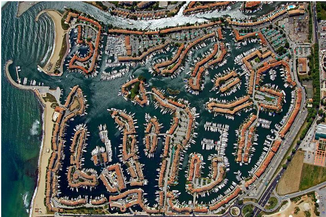
Fot. 36. Port Grimaud – widok z lotu ptaka.
