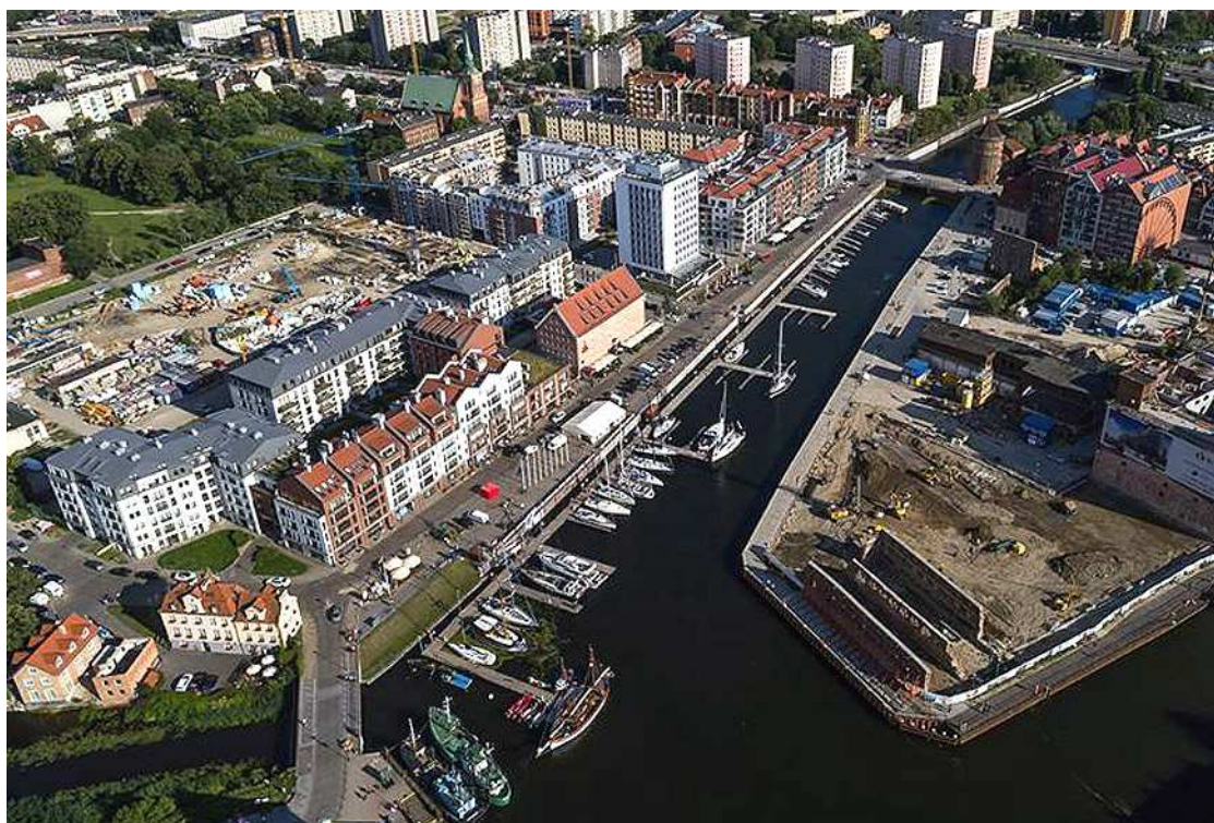
Fot. 120. Gdańsk – przystań na Szafarni.
