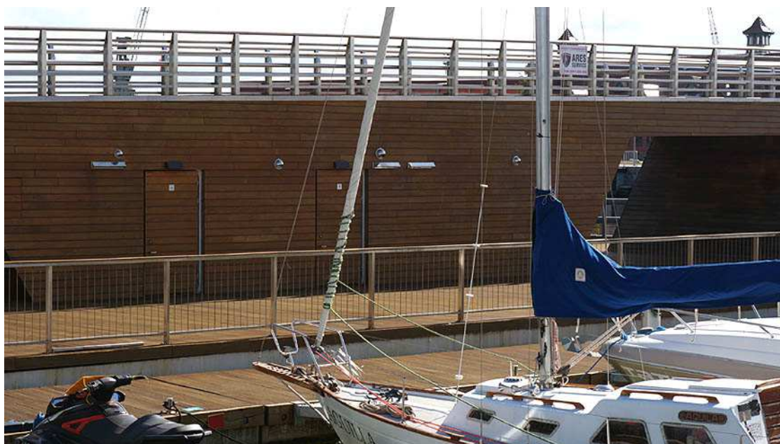
Fot. 87. Widok ściany mostu z wejściami do pomieszczeń sanitarnych dla żeglarzy. Fot. Katarzyna Rembarz (14.09.2018)
