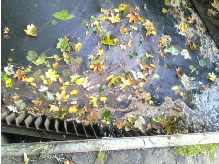
Rys. 3.7. Krata: a) widok z góry, b) dopływ potoku Swelina do piaskownika przez kratę (fot. Marzena Stosik)
