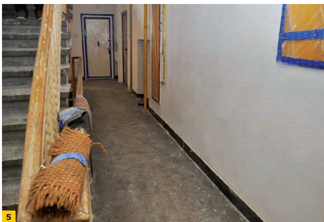
FOT. 5–6. Posadzka typu lastrico na intensywnie eksploatowanym ciągu komunikacyjnym z ruchem pieszym przed (5) i po renowacji (6); fot.: [15]
