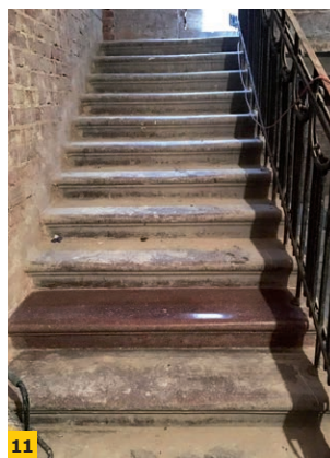
FOT. 11–12. Wytarcie stopnic przedwojennych schodów wykonanych z lastrico jako efekt wieloletniej eksploatacji, przed (11) i w trakcie renowacji (12); fot.: [16]
