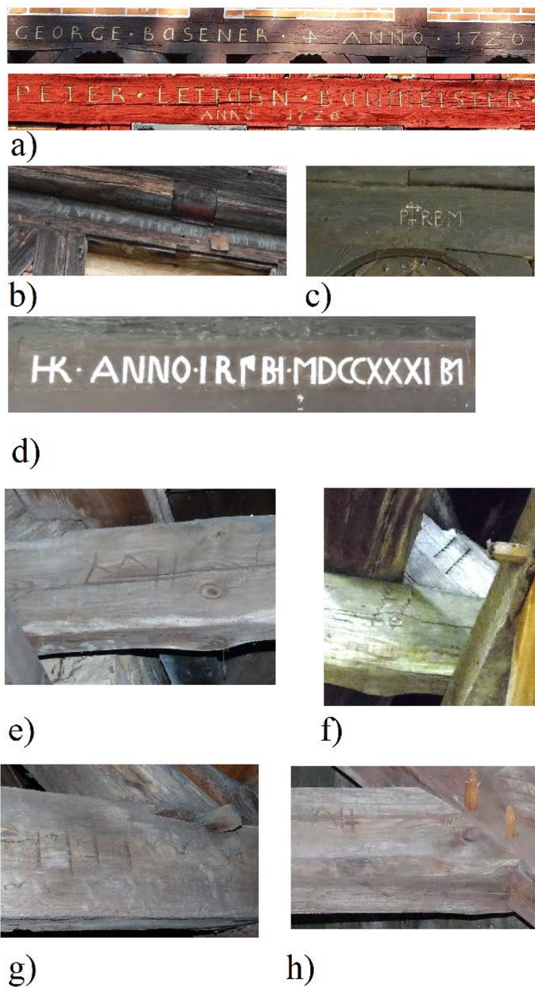
Figure 4. Inscriptions on houses: a) Trutnowy b) Klecie c) Nowa Kościelnica d) Miłocin Carpenters' marks on roof truss elements: e) Trutnowy f) Trutnowy g) Klecie h) Nowa Kościelnica.
