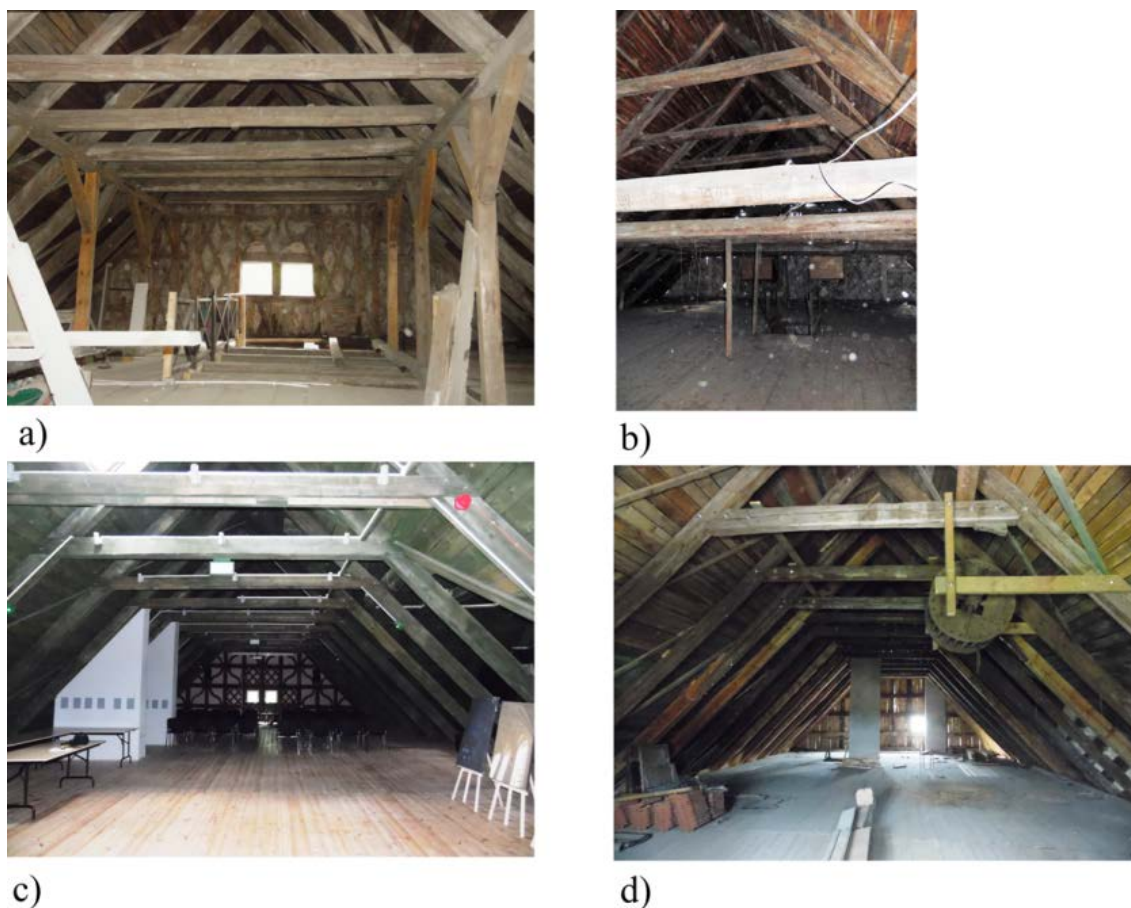
Figure 7. The timber roof truss – current state: a) Trutnowy b) Klecie c) Miłocin d) Nowa Kościelnica
