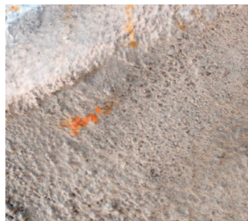
Fot. 2. Zbliżenie na torkret z inhibitorem korozji po 6 miesiącach od naprawy [źródło: Marcin Majewski]
