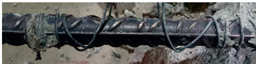
Fot. 5. Widok na chroniony pręt zbrojeniowy w odległości około 40 cm od miejsca podłączenia do protektora [źródło: Marcin Majewski]
