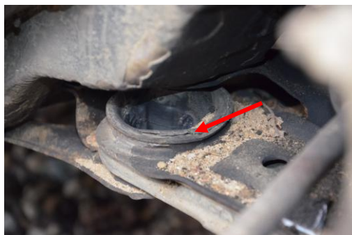
Rys. 4.27. Pęknięcia gumy w tulei metalowo-gumowej wahacza przedniego
