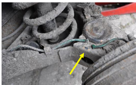
Rys. 4.39. Zaślepiony metalowy przewód hamulcowy przy tylnym lewym kole
