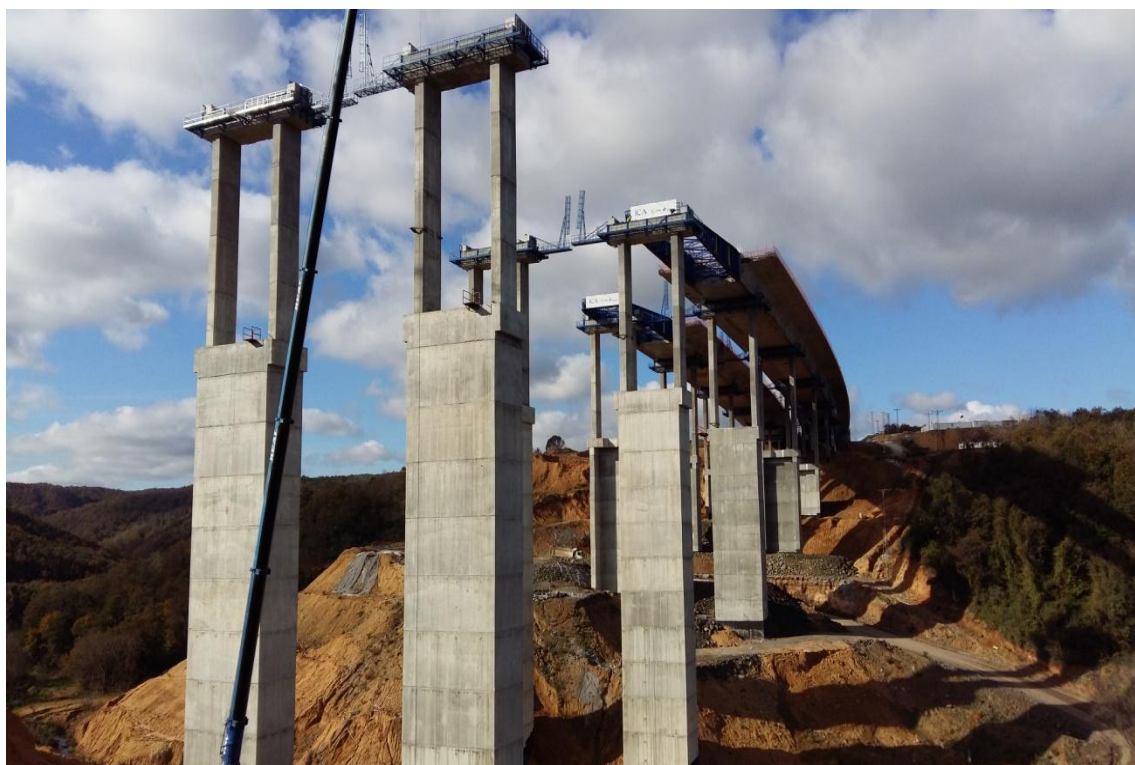
Rys. 37 Zdjęcie z budowy wiaduktu V17 (wrzesień 2014)
