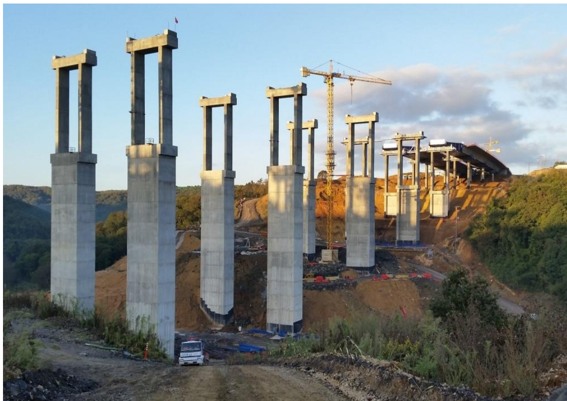
Rys. 36 Zdjęcie z budowy wiaduktu V17 (sierpień 2014)
