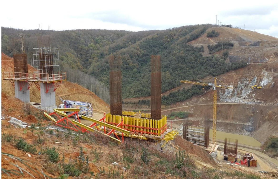
Rys. 35 Zdjęcie z budowy wiaduktu V17 (marzec 2014)
