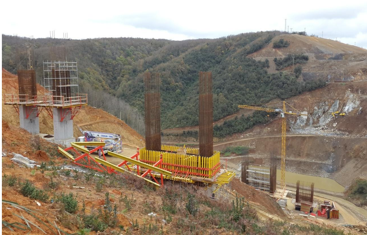
Rys. 35 Zdjęcie z budowy wiaduktu V17 (marzec 2014)
