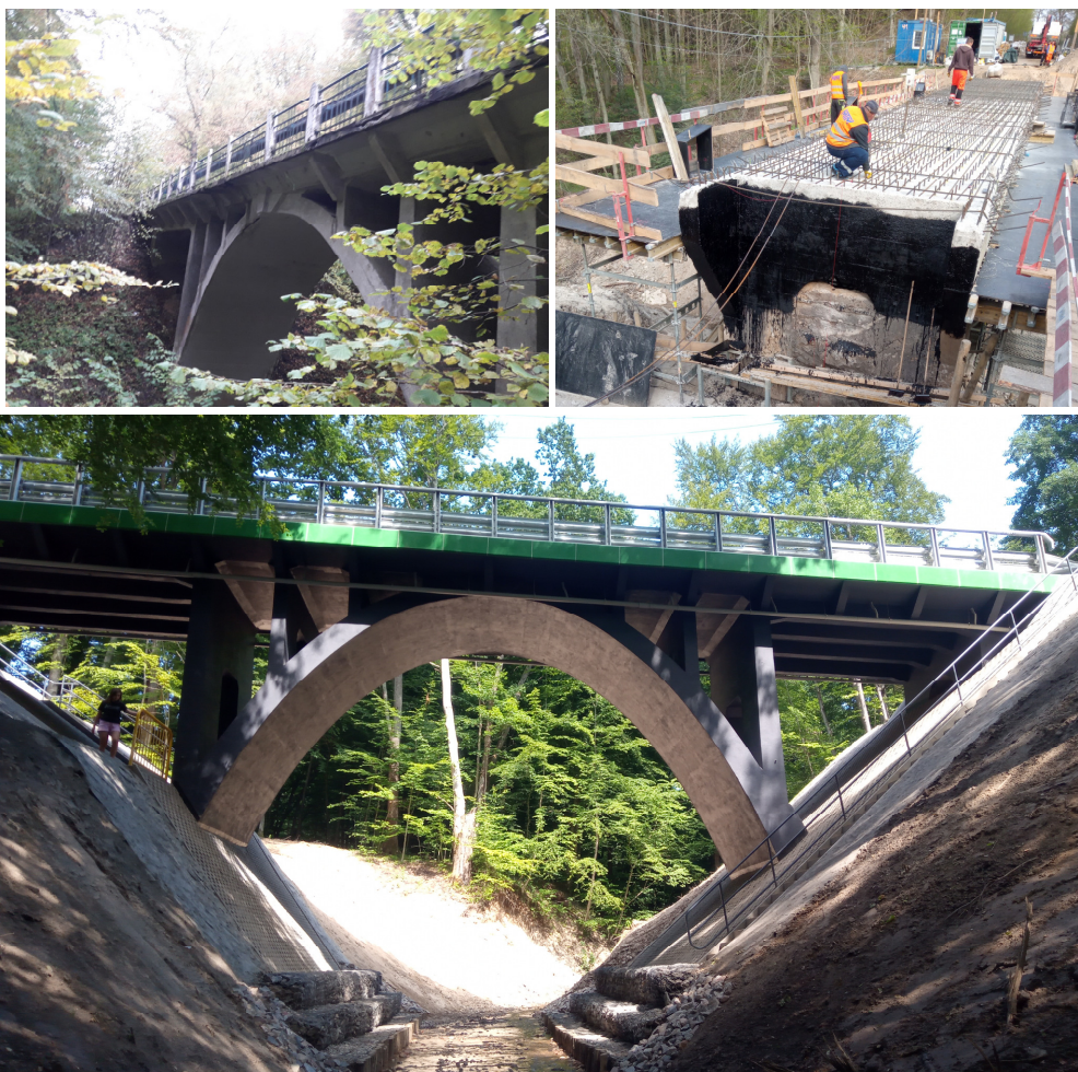
Rysunek 1. Most w Jagodniku w ciągu drogi powiatowej nr 1131N: a) przed przebudową, b) w trakcie przebudowy, c) po przebudowie i oddaniu do użytkowania
