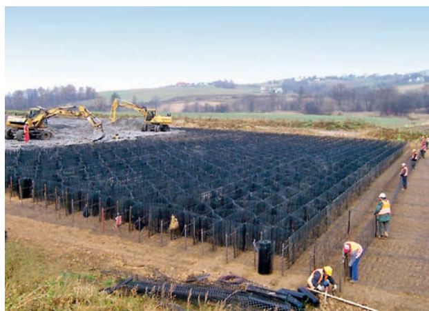
Fot. 2. Konstrukcja geomateraca
