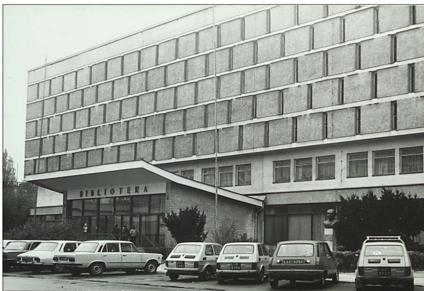
Fotografia 1. Budynek Biblioteki przy ul. Radziszewskiego 11
