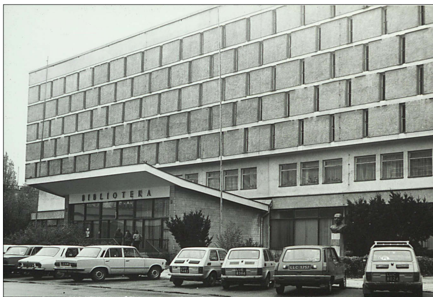
Fotografia 1. Budynek Biblioteki przy ul. Radziszewskiego 11
