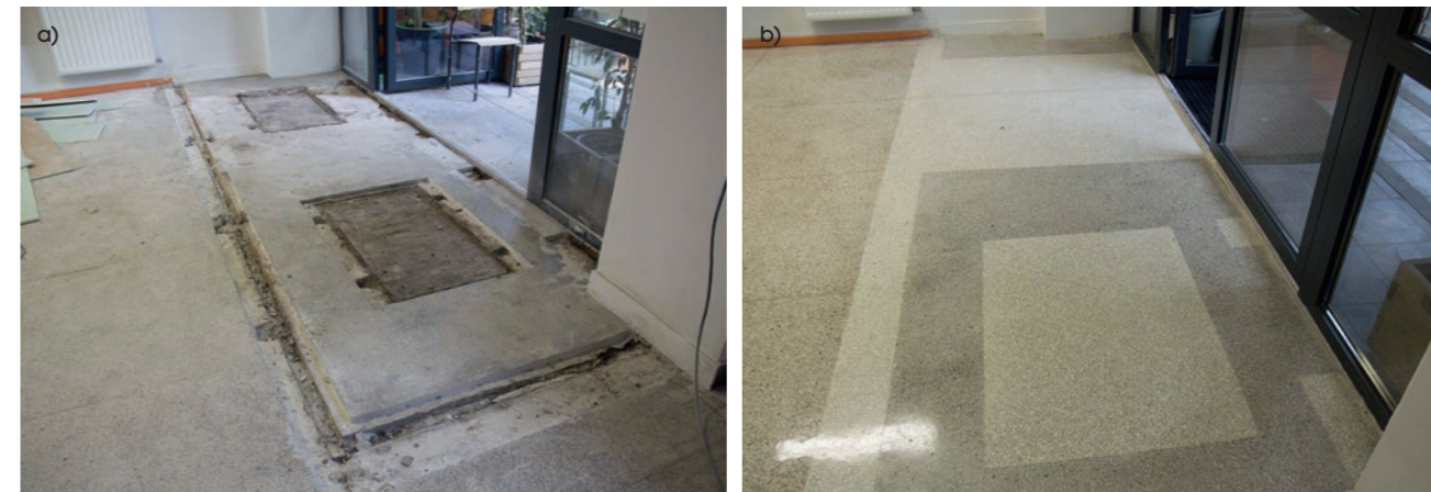
Fot. 2. Naprawa i renowacja posadzki typu lastrico w budynku szkoły – posadzka: a) przed naprawą, b) po naprawie (M1)
