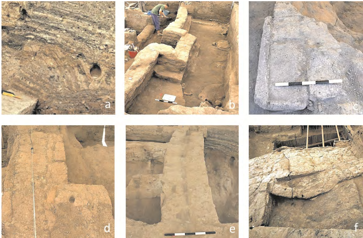
Rycina 112. Przykłady zniszczeń i deformacji obiektów murowanych: a) zawalony fragment ściany budynku B.132 w North Area (fot. J. Quinlan), b) przechylenie się ściany budynku B.103 w TP Area (fot. A. Leszczewicz), c) zgniecenie narożnika budynku B.109 w TPC Area (fot. A. Mickel), d) pęknięcie podłużne fundamentu budynku B.95 w TP Area (fot. A. Leszczewicz), e) wygięcie muru budynku B.52 w North Area (fot. J. Quinlan), f) wygięcie i skręcenie mur budynku B.104 w South Area (fot. J. Quinlan).
