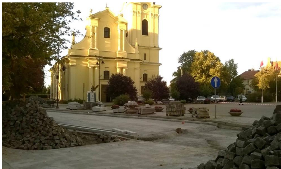
Fot. Il. 17. Remont nawierzchni ul. Wyzwolenia na odcinku rynku. Widoczna elewacja frontowa kościoła Św. Mikołaja p przeprowadzonych pracach konserwatorskich, fot. autorka, 2014
