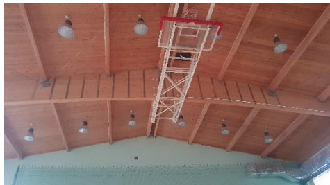
Rys. 4. Wzmocnienie i zabezpieczenie dźwigara dachowego z drewna klejonego w sali sportowej w osi 2: szczegółowe rozwiązanie projektowe – strona: a) lewa, b) prawa, stan zrealizowany - strona: c) lewa, d) prawa
