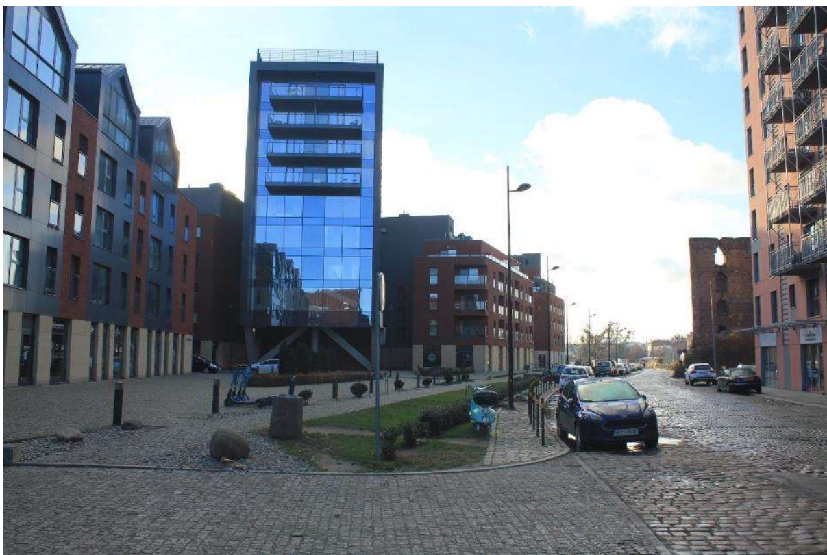
Ryc. 67 Ulica Chmielna, południowa część Wyspy Spichrzów, Gdańsk (fot. M. Izidor)
