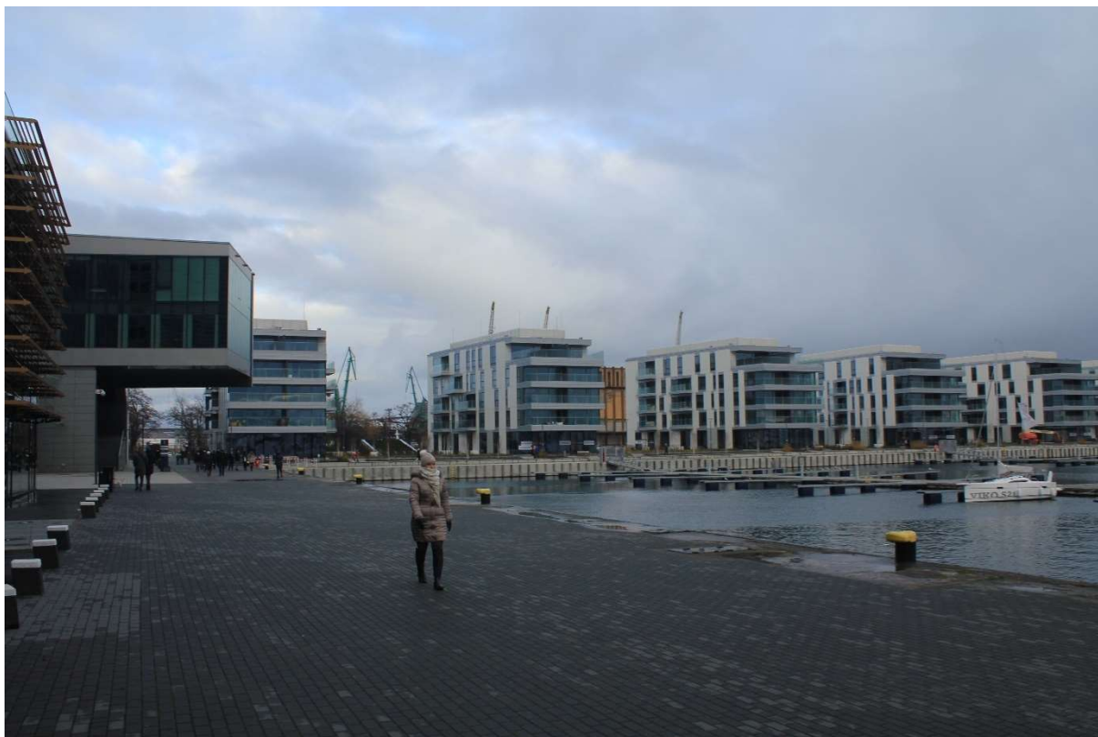
Ryc. 85 Basem Prezydenta, Gdynia, nowe zagospodarowanie nabrzeży (fot. M. Izydor)
