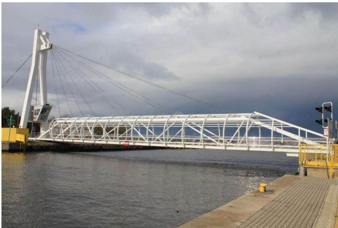
Ryc. 168 Kładka obrotowa w Ustce (fot. M. Izydor)
