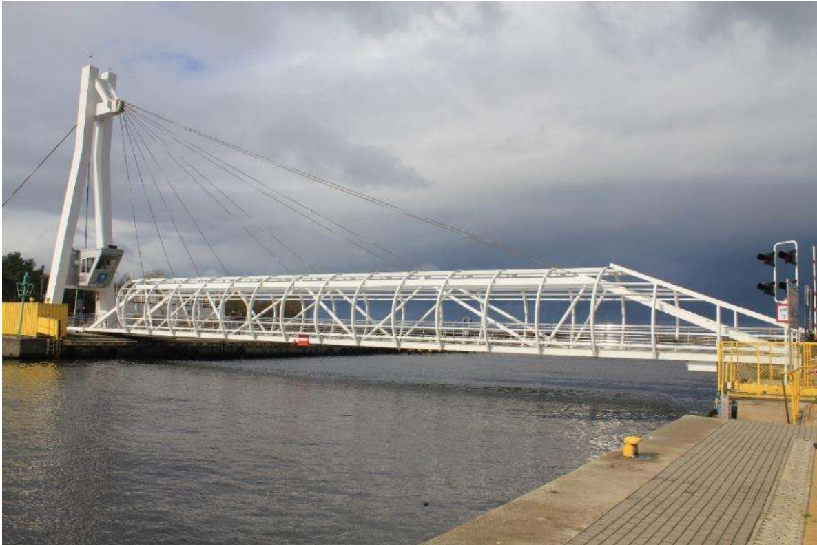
Ryc. 168 Kładka obrotowa w Ustce (fot. M. Izydor)
