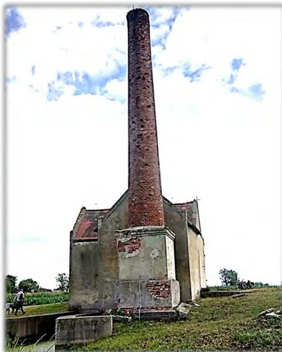
Ryc. 5.12. Budynek przepompowni parowej w Różnach, fot. A. Rubczak (2018)
