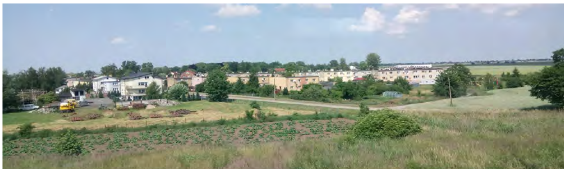
Ryc. 3.10. Zabudowa mieszkaniowa w krajobrazie Żuław Malborskich- budynki mieszkalne z okresu powstania Państwowych Gospodarstw Rolnych (po prawej stronie ulicy) oraz zabudowa, która nie nawiązuje do tradycji regionu Źródło: fot. A. Rubczak, 2018.
