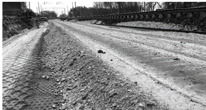
11. Stabilizacja warstwy ochronnej w trakcie modernizacji linii LK 273
