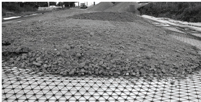
10. Układanie pierwszej warstwy georusztu trójosiowego w trakcie modernizacji linii E65 na obszarze LCS Gdańsk
