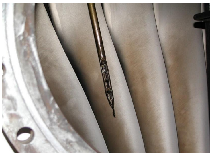
Rys. 3.11. Widok końcówki sondy zamontowanej w przestrzeni pomiarowej za ostatnim stopniem analizowanej turbiny, [47].
