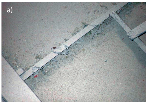
Rys. 7. Widok wierzchu żelbetowego sklepienia kolebkowego SK-1: a) w kluczu, b) wzdłuż gurtu pomiędzy łupinami SK-1 i SK-2
