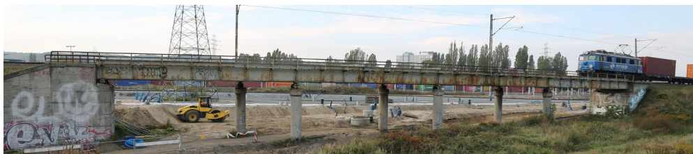
Rys. 1. Widok ogólny na most
