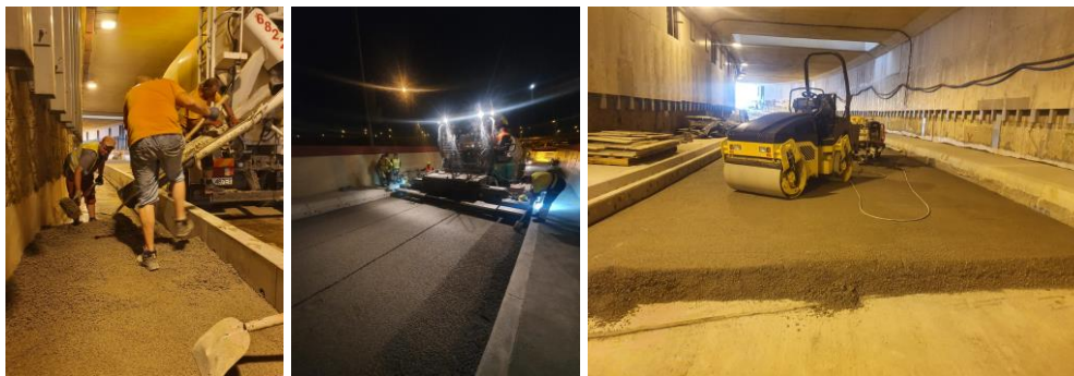
Rysunek 15. Układanie betonu jamistego PERVIA w tunelu na węźle „MPL Okęcie”.
