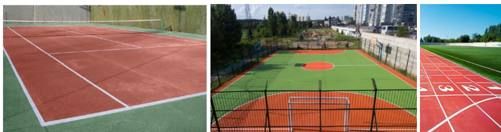
Rysunek 5. Zastosowanie betonu PERVIA w obiektach sportowych.
