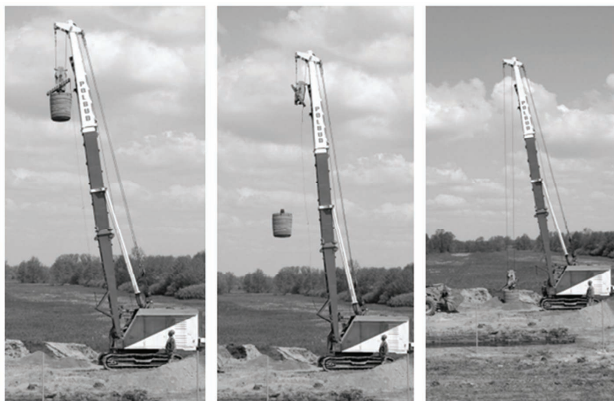
7. Dynamiczne zagęszczanie gruntu, autostrada A2 odcinek Koło-Dąbie (fot. własna)
