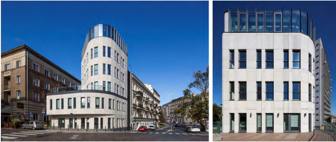
Il. 91, il. 92. Budynek biurowy przy ul. Kopernika w Warszawie, fot. Marcin Czechowicz Źródło: materiały własne Grupa 5 Architekci.
