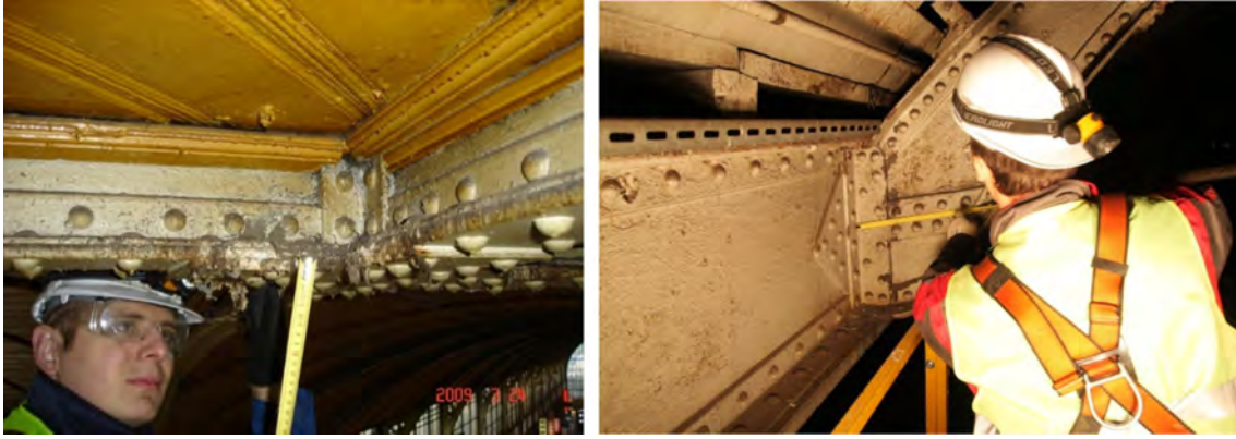
Il. 115, il. 116. Dworzec Wrocław Główny PKP, prace inwentaryzacyjne
