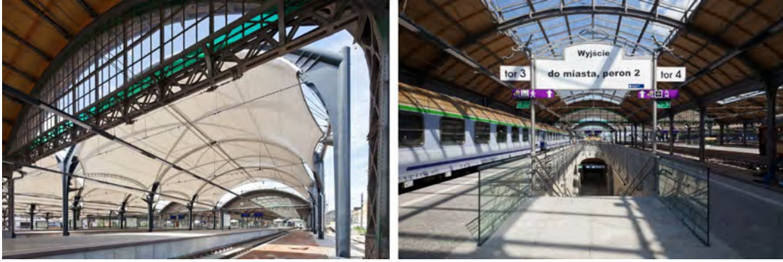
Il. 111, il. 112. Dworzec Wrocław Główny PKP, zdjęcia po realizacji Źródło: materiały własne Grupa 5 Architekci.
