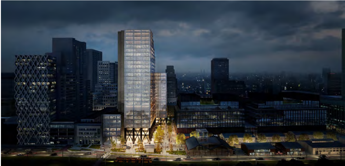
Il. 133. Kompleks biurowy Studio przy ul. Łuckiej w Warszawie Źródło: materiały własne Grupa 5 Architekci.
