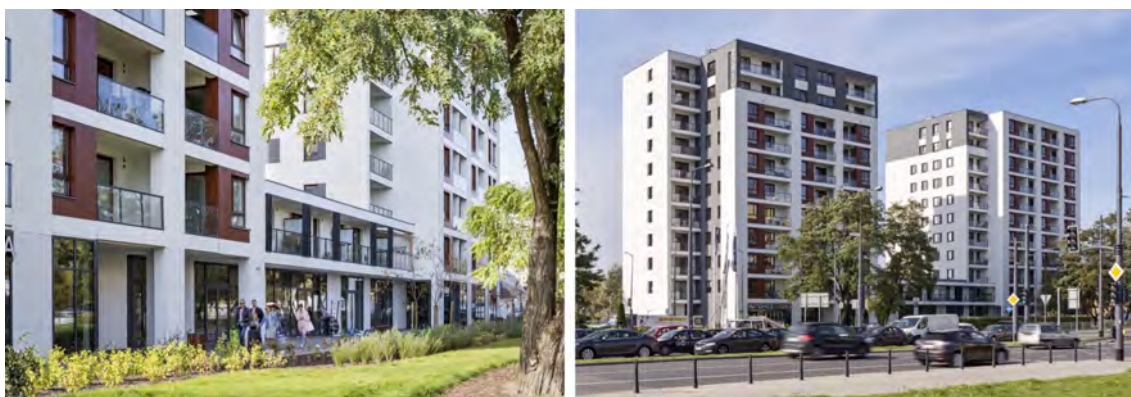
Il. 50. Osiedle Robyga Kameralne Etap 8, ul. Powstańców Śląskich, Warszawa 2016
