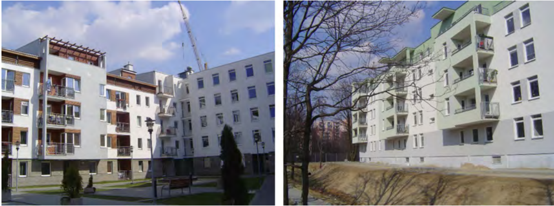
Il. 27, il. 28. Zdjęcia z realizacji osiedla mieszkaniowego Strumykowa 2000 Źródło: materiały własne Grupa 5 Architekci.
