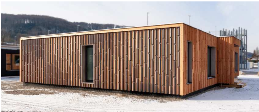
Rys.8a: Demonstracja zastosowania wyników badań projektu CoDeFa na elewacjach tymczasowego budynku biurowego
