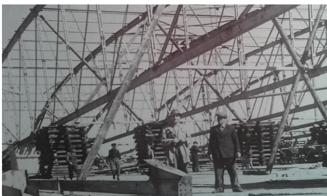
Il. 3.05. Zdjęcie wykonane w trakcie wznoszenie konstrukcji dachu dawnego hangaru lotowskiego, dzisiejszej Galerii Zaspa. Źródło: Fotopolska, https://fotopolska.eu/Gdansk/b51274,Lotnisko_Gdansk-Wrzeszcz,24,48.html?f=963885-foto [dostęp: 12.11.2021].
