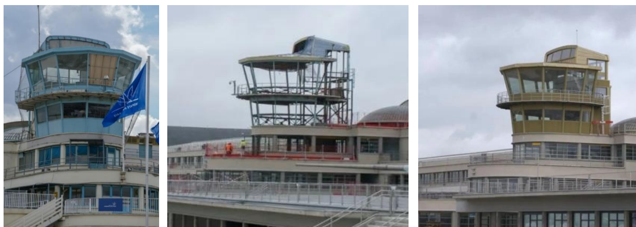
Il. 4.14. Od lewej: Dawna wieża kontrolna w Le Bourget przed remontem, kolejno w trakcie prac, całkowicie rozebrana przed restauracją (05.10.2017), po prawej po zakończeniu prac. Źródło: Restauration de la tour de contrôle du Bourget de 1953 , Passion pour l'aviation, https://www.passionpourlaviation.fr/2019/03/31/restauration-de-la-tour-de-contrôle-du-bourget-de-1953/ [dostęp: 10.06.2020].
