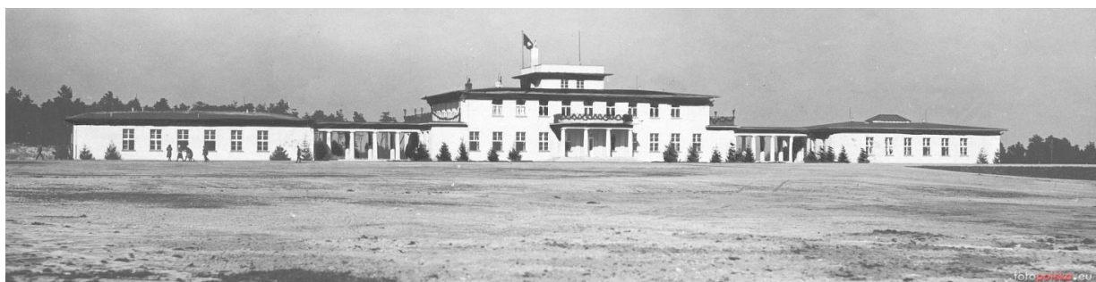
Il. 1.35. Budynek lotniska cywilnego, lata 1929-1931 , widok ogólny. Źródło: NAC- Narodowe Archiwum Cyfrowe Sygnatura 3/1/0/8/4094/5, Sygnatura dawna:1-G-4094-5.
