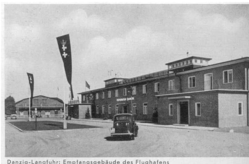
Danzig-Langfuhr: Empfangsgebäude des Flughafens
