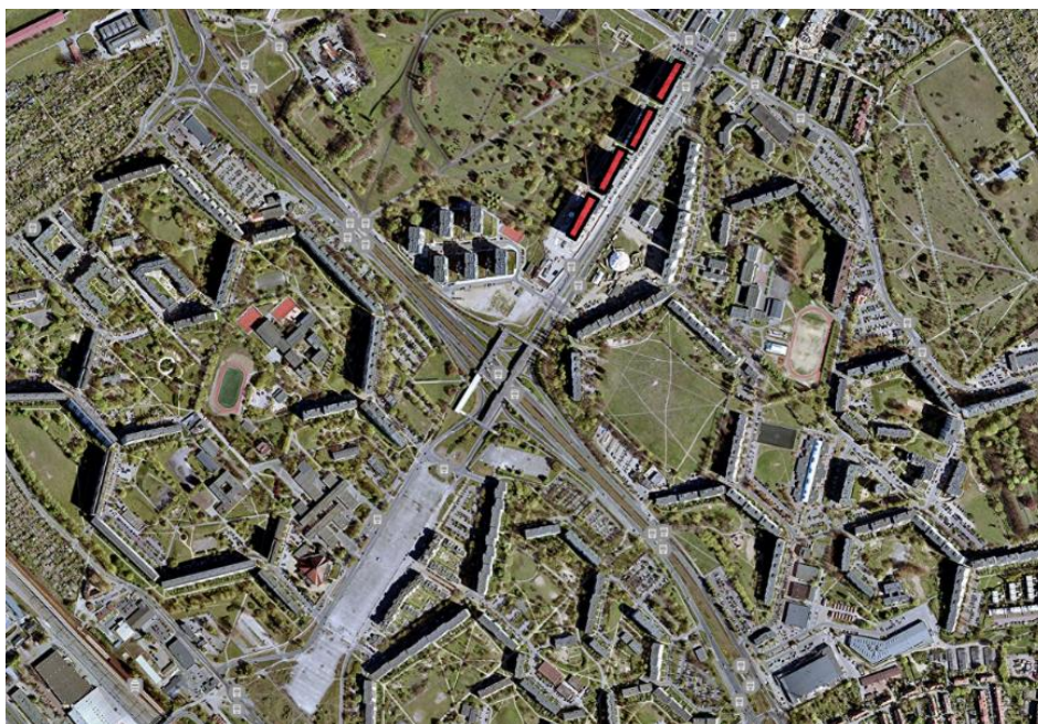
Il. 2.26. Najnowsza realizacja na terenie bylego PL Gdańsk-Wrzeszcz. Czerwonym kolorem oznaczone cztery wielokondygnacyjne budynki mieszkalno-uslugowe. Opracowanie na podstawie Mapy Trójmiasto https://mapa.trojmiasto.pl/#/map/-98.54,83.11,3,0,0;24;37 [dost p: 10.12.2021].
