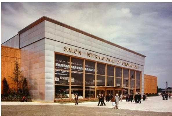
Il. 1.22. Ilustracja po lewej: Fasada hali wystawowej po przebudowach (A1), okładzina z paneli aluminiowych oraz drewniana stolarka. Źródło: H. Caroux, Le Hall d'exposition de l'aéroport du Bourget , Museum International , In Situ Revue des patrimoines, 2018, nr 35, str. 10.
