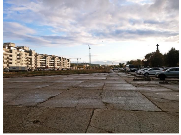
Il. 1.148. Widok na pas startowy, rozpoczęcie prac budowlanych, październik 2019. Fot. A. F. Szuta
