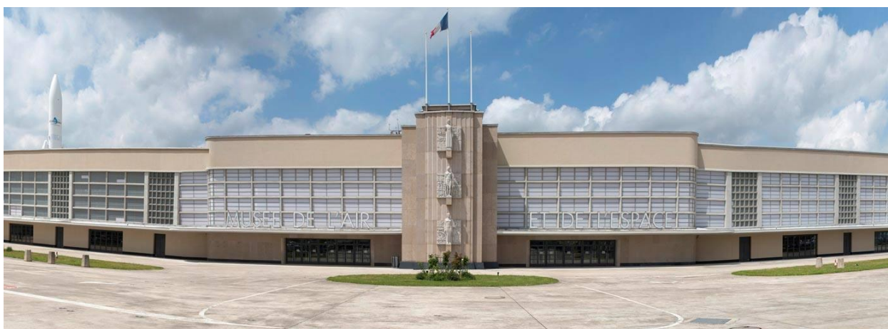
Il. 4.12 Fasada terminalu po remoncie. Źródło: Oficjalny profil Musee de l'Air et de l'Espace na portalu Facebook, 04.09.2018, https://www.facebook.com/museedelairtdelespace/photos/10155742524528807/ [dostęp: 20.03.2021].
