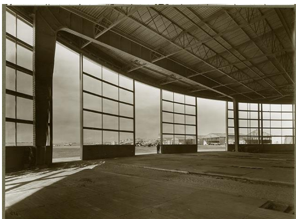
Il. 1.20. Wnętrze hali zaprojektowanej przez André Graneta. Po lewej widoczne świetliki dachowe, po prawej wyjście na lotnisko przez przesuwne drzwi w przeszklonej, zaokrąglonej fasadzie. Źródło: H. Caroux, Le Hall d'exposition de l'aéroport du Bourget , Museum International, In Situ Revue des patrimoines, 2018, nr 35, str. 9.
