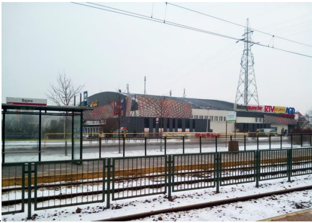
Il. 1.147. Hangar zaadoptowany na centrum handlowe, widok z przystanku tramwajowego Gdańsk – Bajana, 2019 r. Fot. A. F. Szuta
