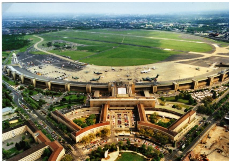
Il. 1.36. Lotnisko Tempelhof, 1989. Widoczne wieże schodowe rozmieszczone na eliptycznym segmencie. Źródło: https://www.mil-airfields.de/de/berlin-tempelhof-central-airport.htm [dostęp: 20.03.2021].
