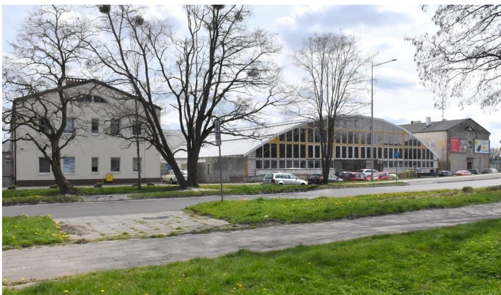
Il. 1.103. Hangar po remoncie. Fot. A. F. Szuta, 01.05.2022.
