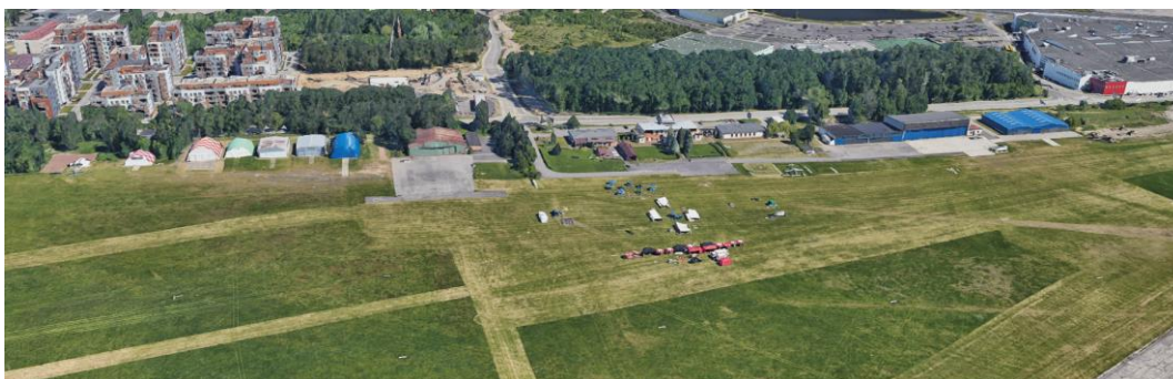
Il. 1.38. Widok satelitalny na infrastrukturę byłego lotniska. Źródło: Googlemaps 50°14'23.0"N 19°02'07.3"E.
