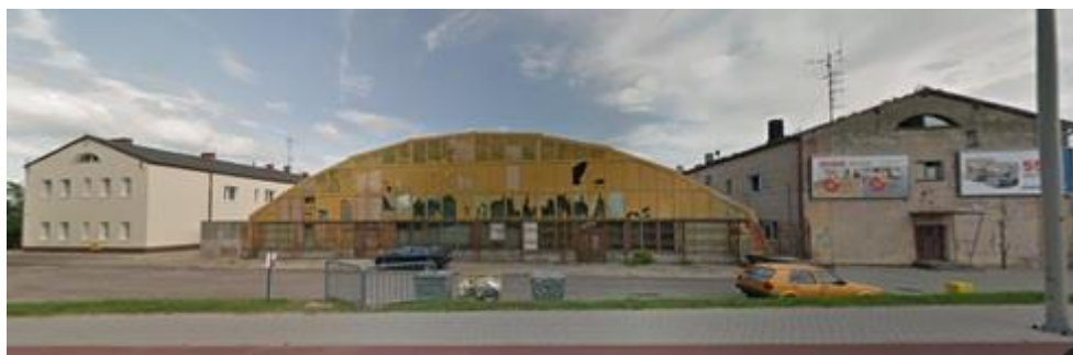
Il. 1.102. Hangar przed remontem. Źródło: Googlemaps, 54°27'07.0"N 17°00'03.4"E [dostęp: 05.06.2021].
