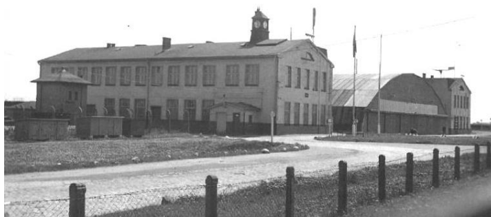
Il. 1.101. Hangar o konstrukcji łukowej wzniesiony w 1937 r. Sąsiaduje z budynkiem kancelaryjnym (pozostałość po hangarze remontowym z okresu I WŚ). Źródło: M. Kabatek, Lotnictwo w Słupsku 1912-1945 , Stratus, Sandomierz, 2016, str. 45.
