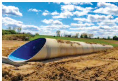
Fot. 2. Przepust drogowy z tworzywa GRP o profilu niekołowym o wymiarach 3000/2250 na trasie S6 Szemud – Gdynia Wielki Kack [1]
