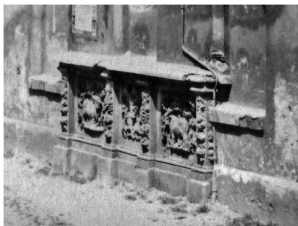
Ryc. 7. Detal dekoracji rzeźbiarskiej fasady budynku jatek mięsnych na podstawie zdjęcia ze zbiorów P. Popińskiego (ryc. 6)
