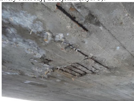
Rys. 3. Spód płyty pomostu
