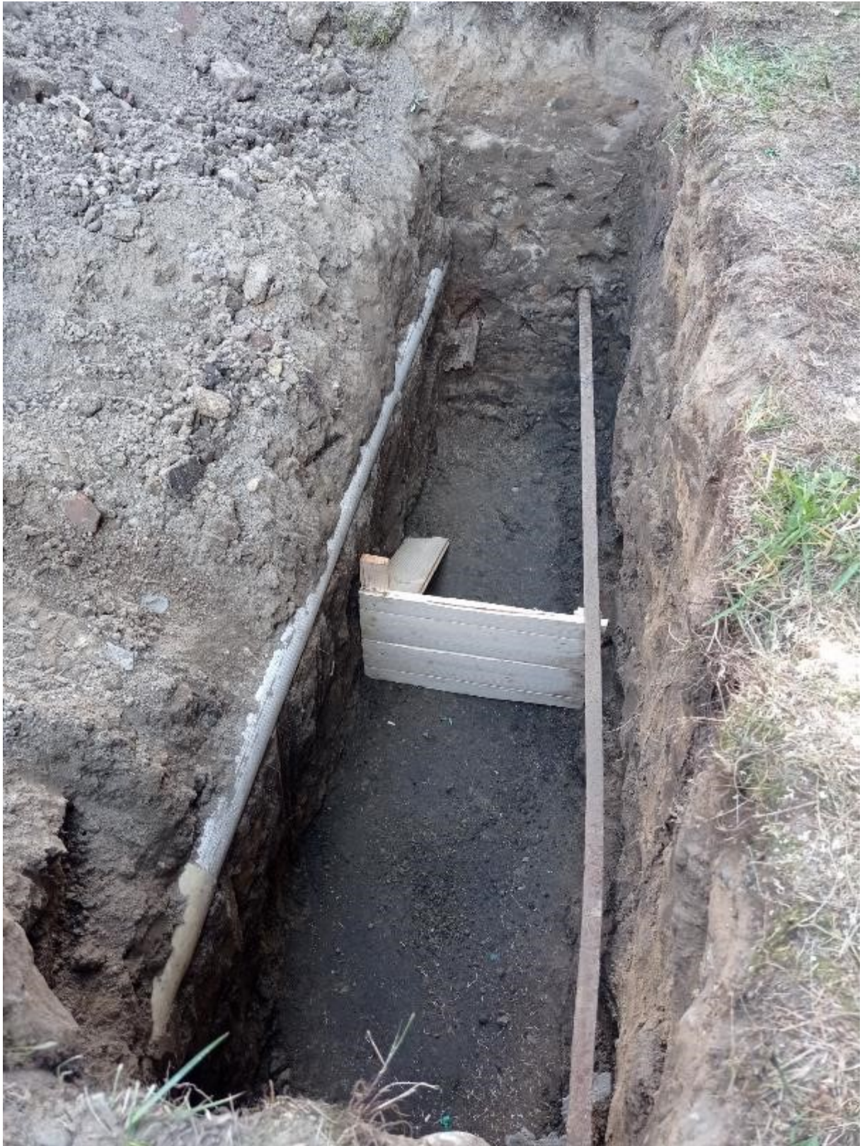
Rysunek 39. Widok rowu kablowego. Po bokach widać elementy istniejącej infrastruktury podziemnej. W centralnej części fotografii bariera do separacji stanowisk (odcinek bez z folii i odcinek z folią)
