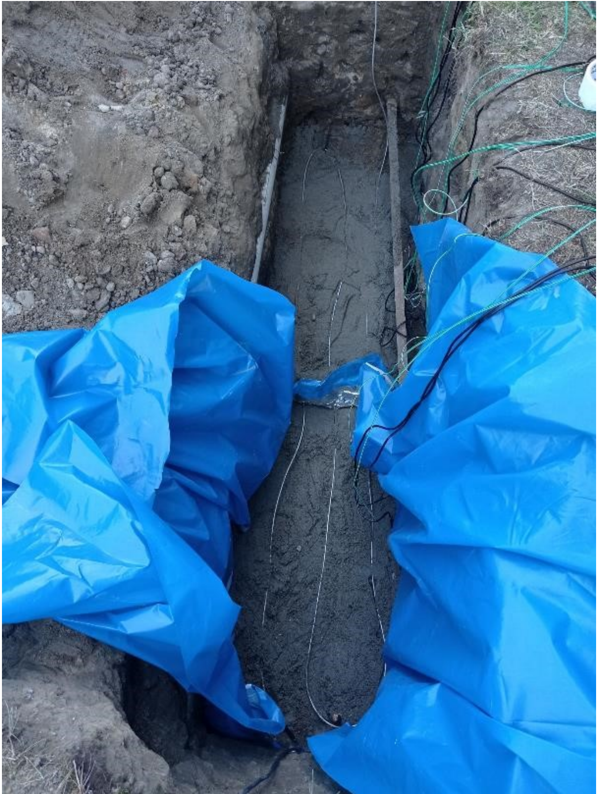
Rysunek 44. Ułożenie przewodu grzejnego symulującego linię kablową (źródło ciepła) na obu stanowiskach pomiarowych. Dno rowu wypełnione betonem
