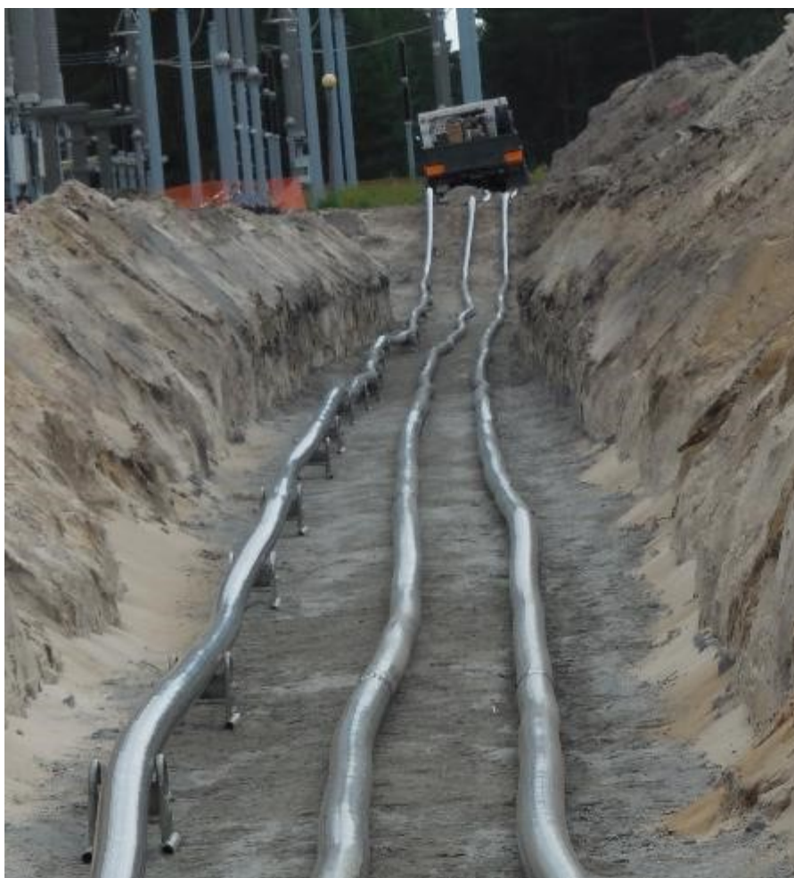
Rysunek 8. Proces układania linii kablowej w wykopie. Na otulinę, będącą mieszaniną piasku i cementu układane są kable w układzie płaskim. Kabel po lewej jest przeciągany na rolkach, które mają za zadanie spowodować uniknięcie ciągnięcia kabla po podłożu. Rysunek pochodzi z firmy Eltel Networks Energetyka SA
