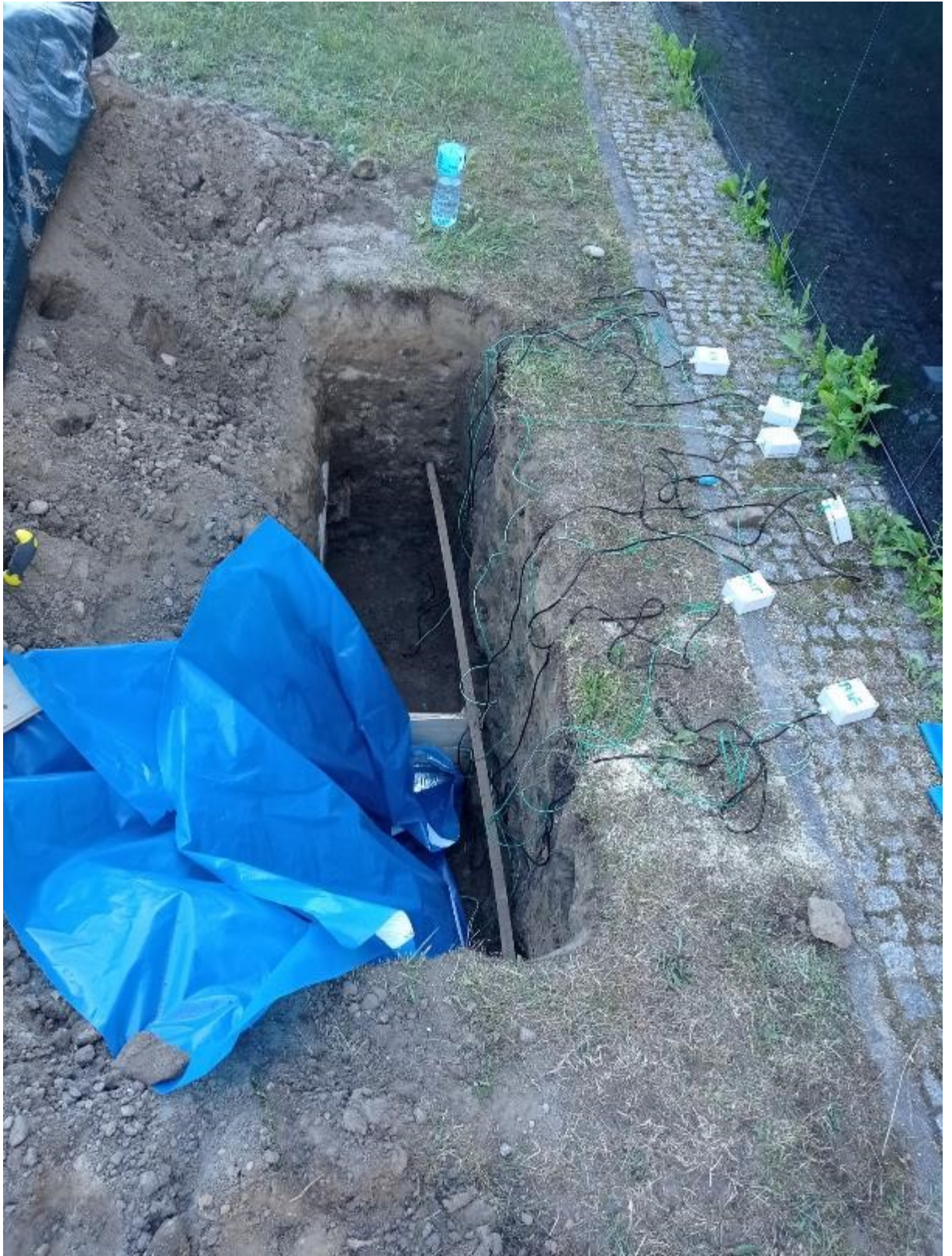
Rysunek 42. Przygotowanie folii paroizolacyjnej wraz z miernikami
