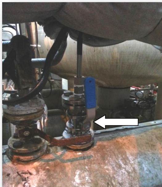
Rysunek 47. Miejsca montażu czujników LPR.
