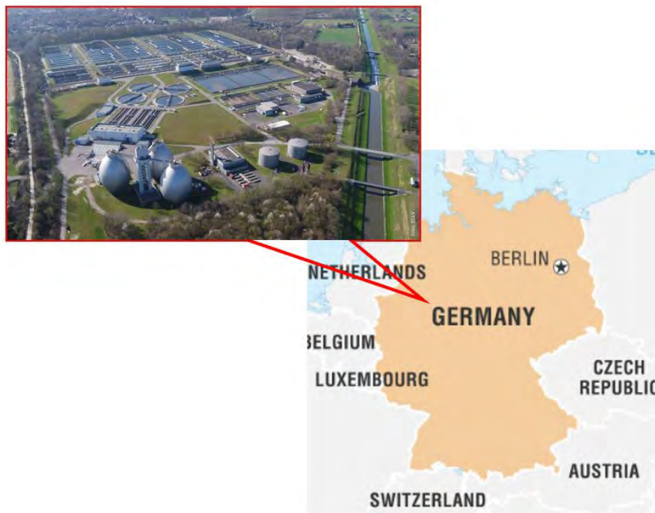
Figure 11- Emschermündung WWTP in Dinslaken, Germany
