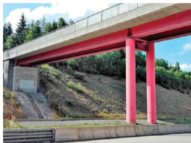
Przykład zastosowania słupów CFST w konstrukcji zespolonego stalowo-betonowego obiektu mostowego nad autostradą A93 między Hof i Ratzboną w Niemczech
