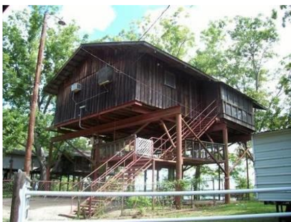
Rys. 3.41. Dom o elewacji statycznej w południowej Luizjanie. Jest to strategia łagodzenia skutków powodzi promowana obecnie przez agencje rządowe USA. (English, 2009)
