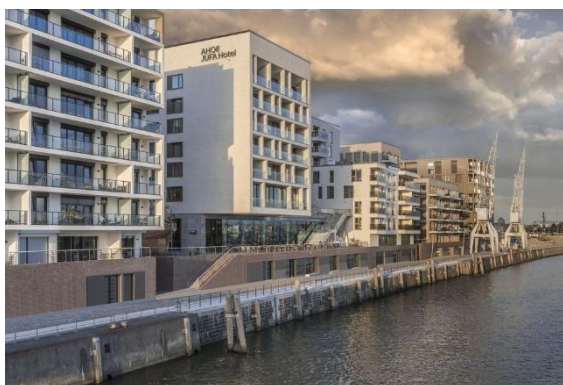
Rys. 3.46. Kompleks mieszkaniowo-hotelowy na nabrzeżu w Hamburgu. (PORR, n.d.)
