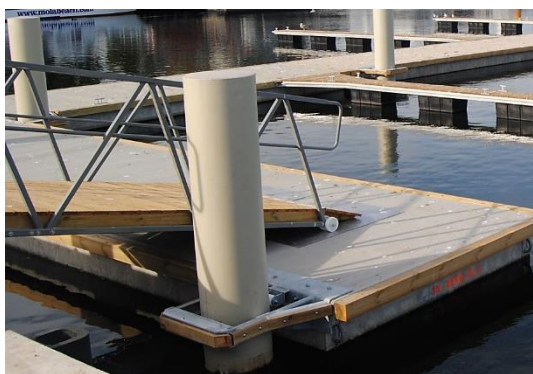
Rys. 3.61. Dalba cumownicza. (Impostal, n.d.)
