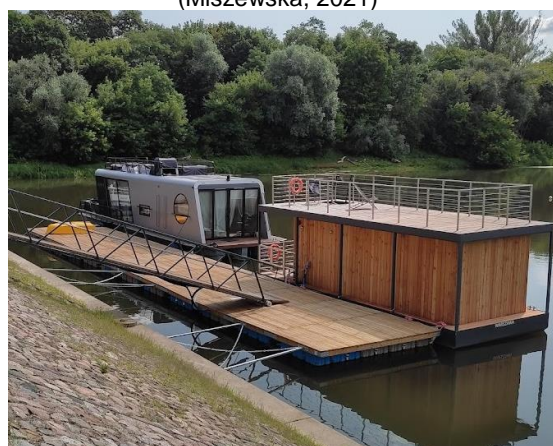
Rys. 3.30. Port Czerniakowski – Domy Na Wodzie – widok 4. (Miszevska, 2021)
