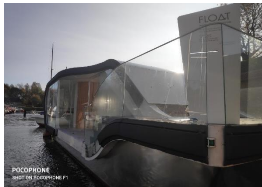
Rys. 3.36. Obiekt na wodzie, okolice Twierdzy Wiosłujcie – Gdańsk – widok 2. (Miszevska, 2020)
