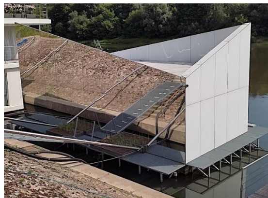
Rys. 3.28. Port Czerniakowski – Domy Na Wodzie – widok 2. (Miszevska, 2021)
