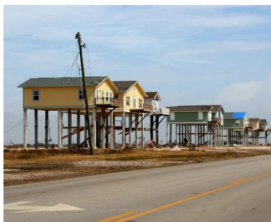
Rys. 3.42. Dom o elewacji statycznej na półwyspie Boliva, Teksas, Stany Zjednoczone. (Henshall, 2018)
