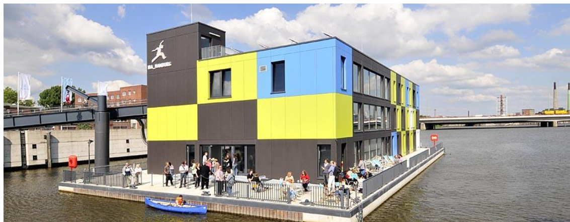
Rys. 3.15. Największy w Niemczech budynek wystawienniczo-biurowy zbudowany w porcie celnym w Muggenburg. Obecnie siedziba IBA Hamburg GmbH od 2010 r. (IBA Hamburg GmbH, n.d. c)
