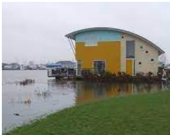
Rys. 3.44. Dom amfibia w czasie powodzi, styczeń 2011. (Factor Architecten, 2011)
