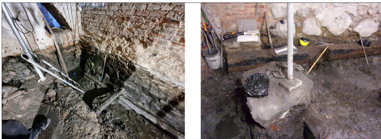
Ryc. 3. Widok elementów odkrytych podczas wykonywanych wykopów; a – baszta południowa, b – baszta północna, 2022; fot. M. Zielińska, S. Sojak
