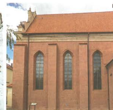
10. Barczewo. Kościół Świętego Andrzeja. Elewacja wschodnia, stan po konserwacji z rekonstrukcją kolorowych tynków, trzech dużych okien i sygnaturki, 2022 roku. Fot. Damian Kwiecień – Gorek Restaura.
