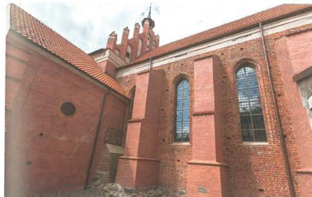
11. Barczewo. Kościół Świętego Andrzeja. Widok elewacji południowej prezbiterium, stan po ukończeniu prac konserwatorskich, 2022. Fot. Damian Kwiecień – Gorek Restaura.
