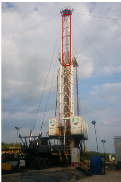
Rysunek 65 Wiertnia z widocznym systemem bloczkowym umożliwiającym zapuszczanie i wyciąganie kolumny rur
