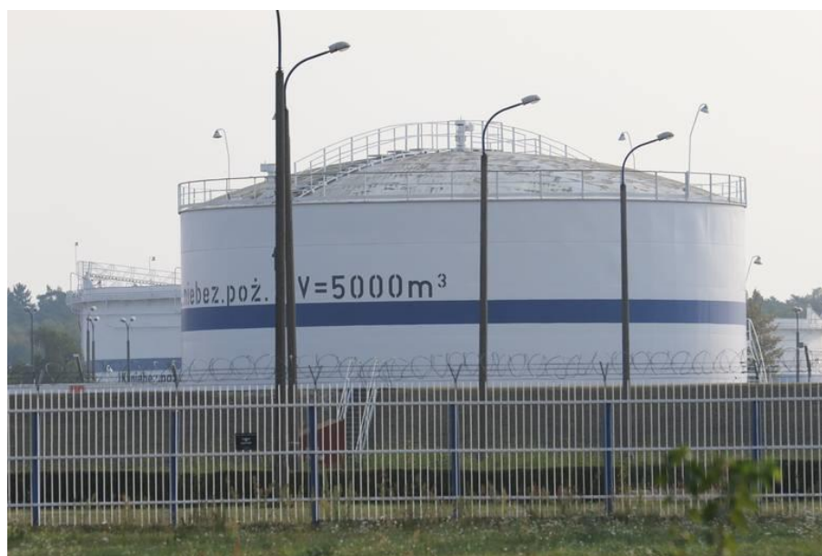
Rys. 2.2. Zbiornik z dachem stałym zlokalizowany na terenie Bazy Paliw nr 2 OLPP Sp. z o.o. w Nowej Wsi Wielkiej ( http://pomorska.pl )
