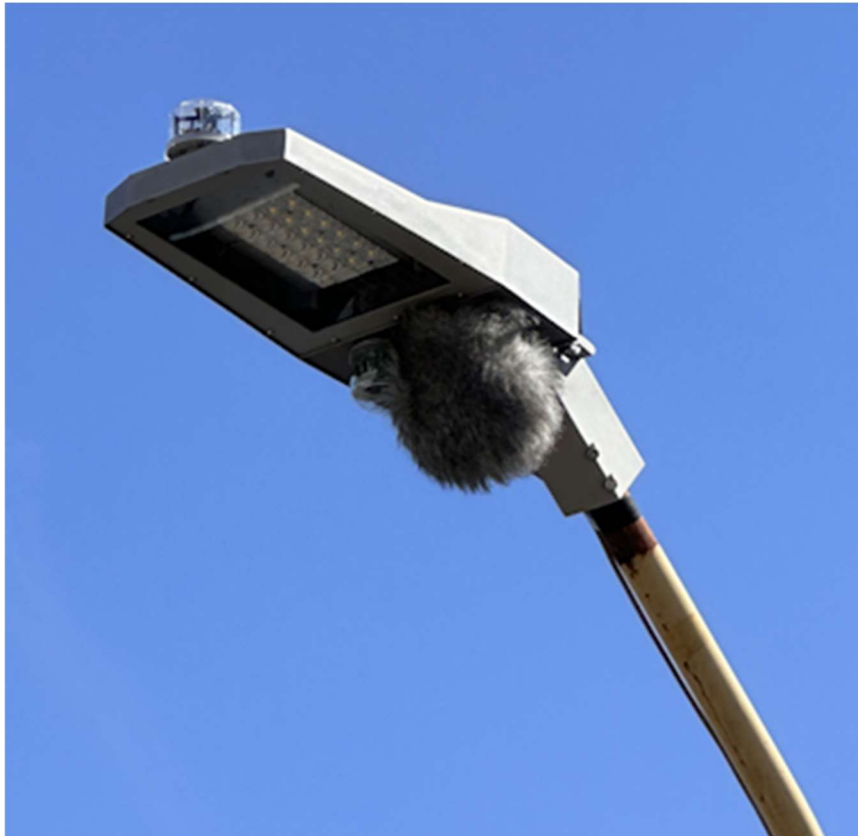
Fot. 13. Lampa inteligentna drogowa ILED z Modułem Głównym, Modułem Radarowym, Modułem Sondy Akustycznej i modułem czujnika temperatury barwowej oświetlenia otoczenia
