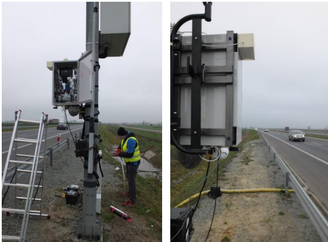
Rys. 60. Moduł pomiarowy w trakcie montażu przy drodze S7
