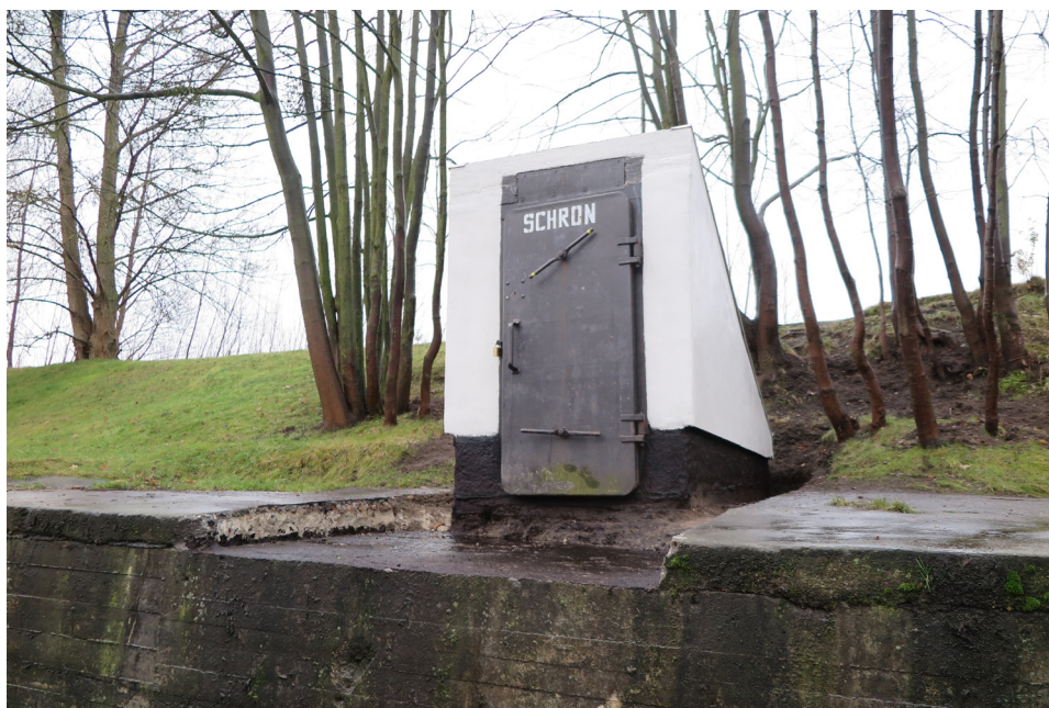
Ryc. 3 Schron przy ul. Morskiej w Gdyni Leszczynkach, po rewaloryzacji przez Gdyński Klub Eksploracji Podziemnej (fot. Biuro MKZ w Gdyni)
