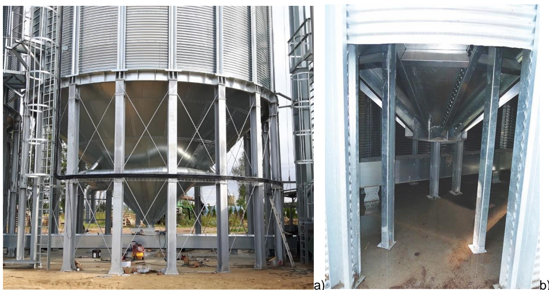
Rys. 1.2: Silos z blachy falistej wzmocniony słupami z dnem lejowym: a) bez uźebrowania i b) z uźebrowaniem [11].
