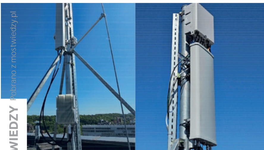
Fot. 3. Terenowy punkt instalacyjny – głowica radiowa 5G MIMO 2x2 z anteną obsługującą obszar południa Zatoki Gdańskiej oraz brama sieci LoRaWAN (po lewej); głowica radiowa 5G MIMO 4x4 oraz antena przeznaczona do pracy w paśmie n77 (po prawej)
