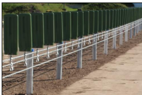
Rys. 2.11 Bariera z prowadnicą linową
