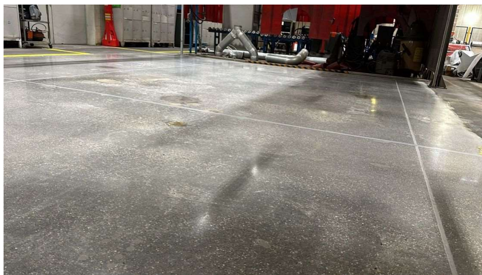
Rys. 10.8. Betonowa posadzka przemysłowa (Przykład 1) po naprawie: widok ogólny oraz widoczne odtworzone i uzupełnione dylatacje skurczowe [M1]
