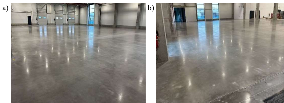
Rys. 10.12. Betonowa posadzka przemysłowa (Przykład 3) po renowacji w procesie polerowania i impregnacji: a) widok ogólny, b) widok na obróbkę nawierzchni w obszarze występowania dylatacji konstrukcyjnych [M1]
