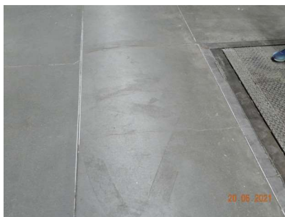
Rys. 8.4. Nieprawidłowe wymiary pola dylatacyjnego: błędny stosunek boków pola posadzki w strefie doków ( fol. S. Świątek-Żołyńska )
