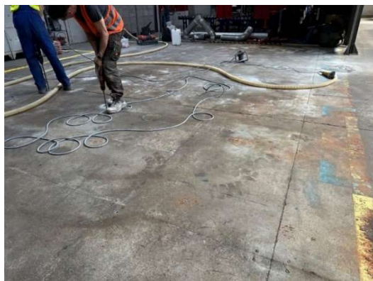
Rys. 10.2. Zdegradowana betonowa posadzka przemysłowa (Przykład 1) podczas naprawy: inwentaryzacja uszkodzeń, usuwanie kotew montażowych [M1]
