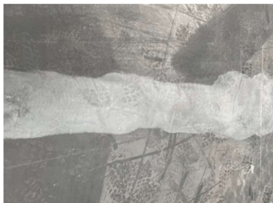
Rys. 10.5 Betonowa posadzka przemysłowa (Przykład 1) podczas naprawy: wykonanie uzupełnienia niecki powstałej po demontażu kanału technologicznego [M1]
